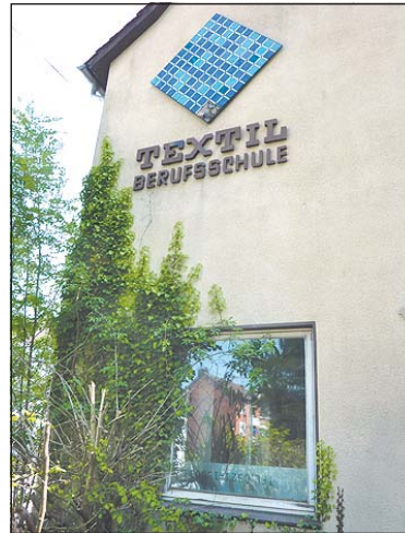
So sah die Textilberufsschule bis zu Renovierungsbeginn aus.
